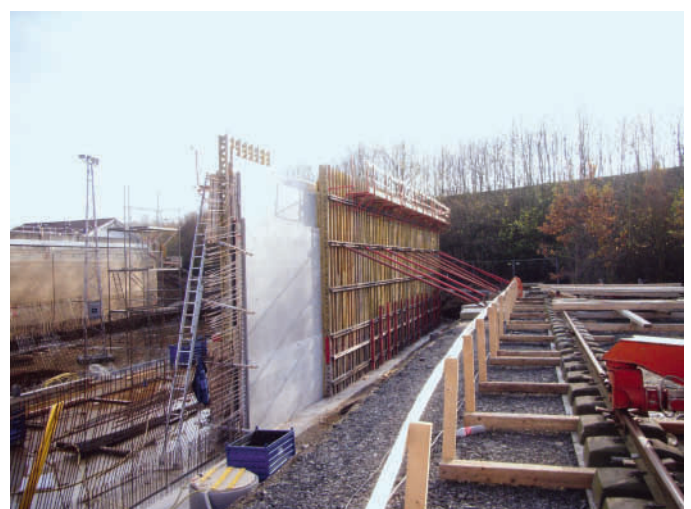
Bild 6: Abschnittsweise Herstellung der Längswände unter Einsatz von Abschalelementen
