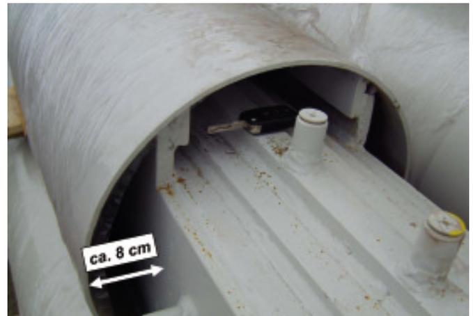
Bild 2. Der Abstand zwischen Kern und Mantelrohr beträgt hier  $\leq 8$  cm
