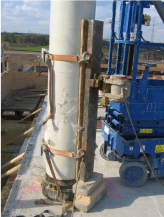
**Bild 14. Verdichtung mit Außenrüttler und Stahlprofilbohle**
