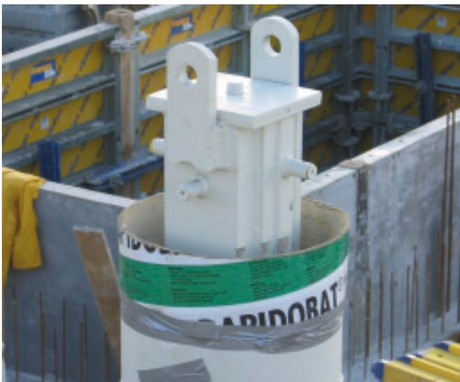
**Bild 15. Schalungsaufdopplung zur Herstellung von Überbeton**
