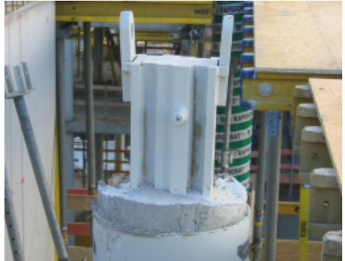
**Bild 16. Ausgeschalter Überbeton**
