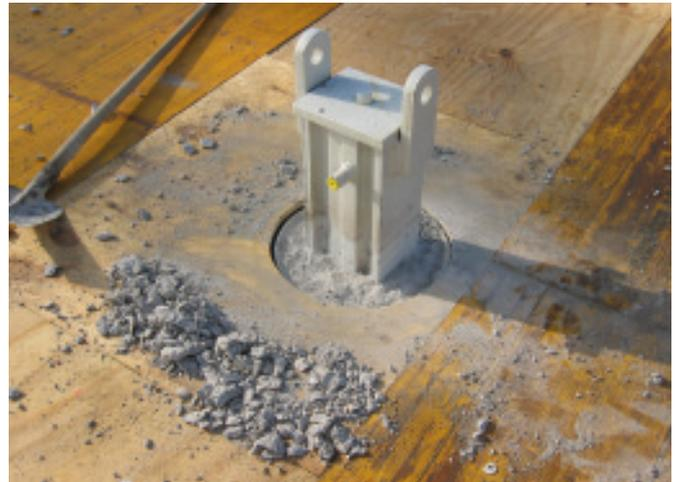
**Bild 17. Abbruch des Überbetons auf Sollhöhe**
