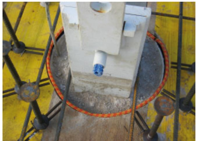
**Bild 18. Abdichtung der Fuge zwischen Mantelrohr und Schalung**
