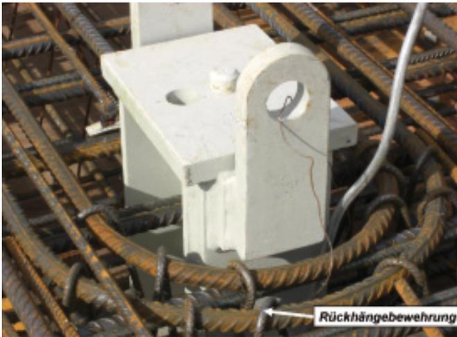
Bild 7. Ausführung der Schlaufen mit zusätzlicher Rückhängebewehrung
